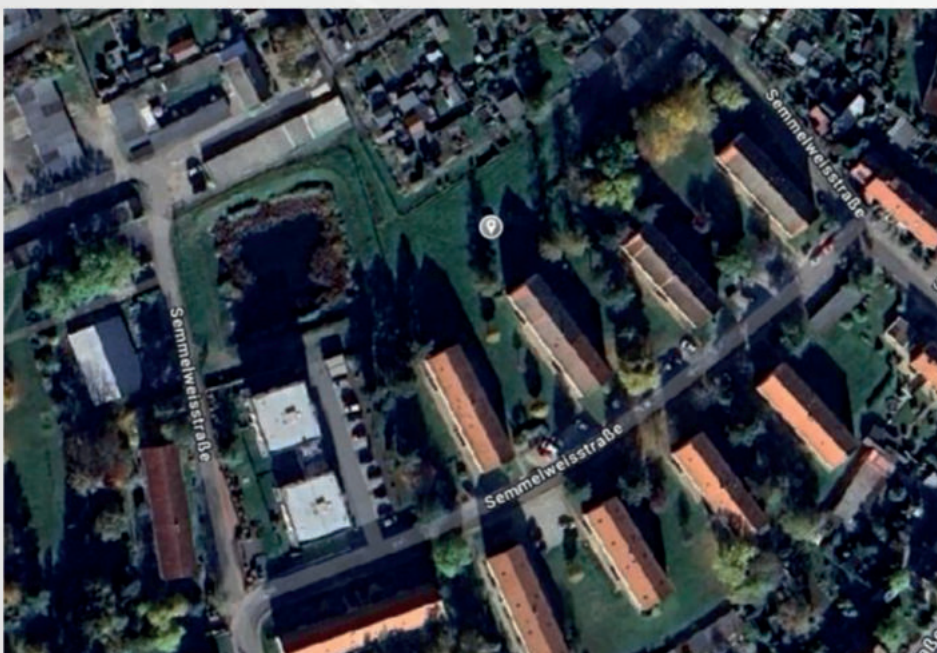
Luftbild von dem Areal in der Semmelweisstraße, auf dem das Mehrfamilienhaus entstehen wird. Quelle: Ingenieurbüro Mario Frommhold
